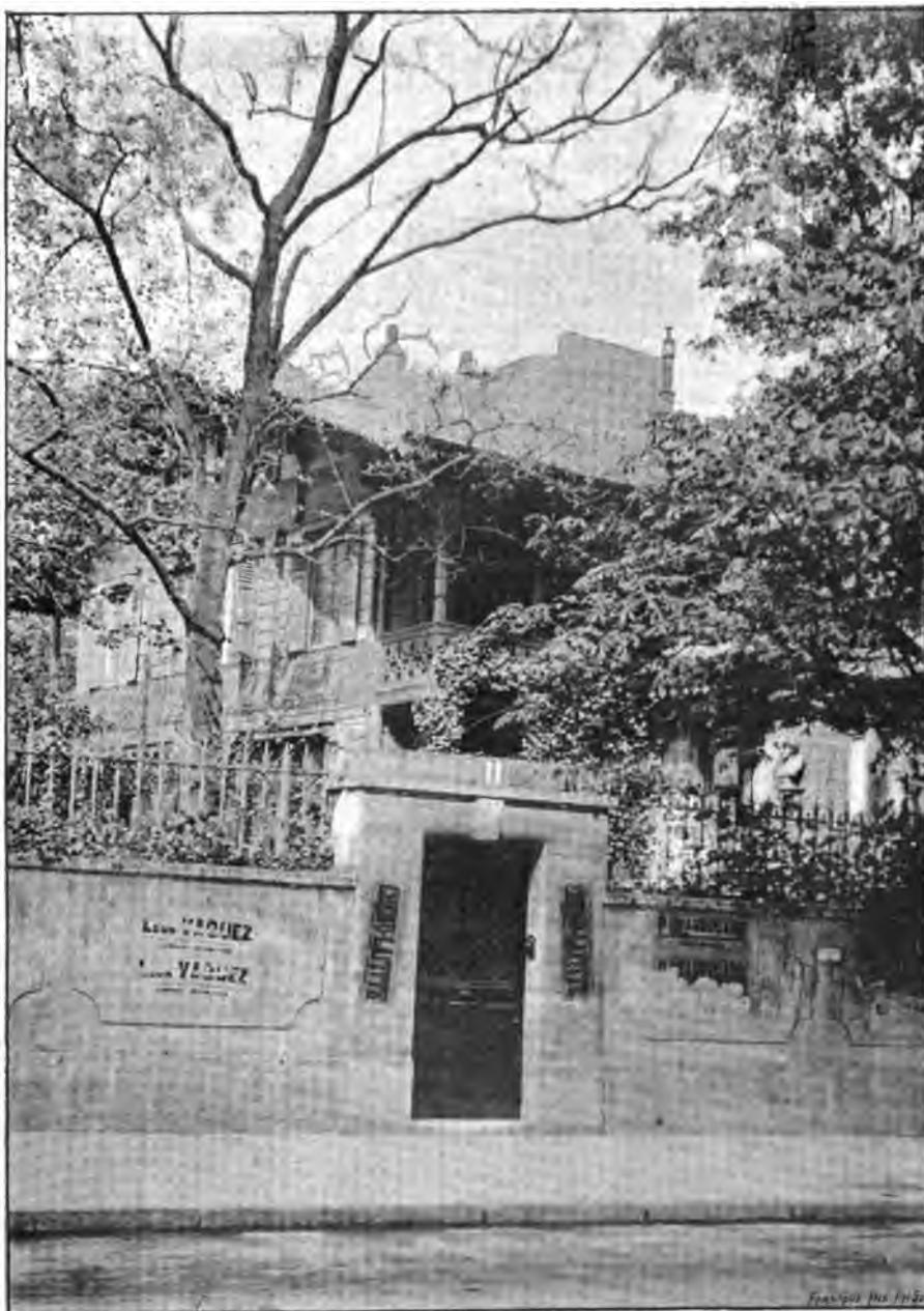
Le chalet de Jules Janin et le bâtiment annexe : l'entrée, 11, rue de la Pompe, avant la démolition.
