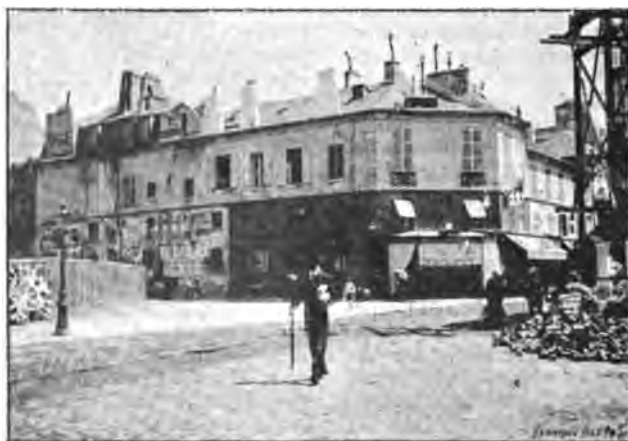
Vue extérieure de la maison, 84, rue de Passy, et 1, rue de la Pompe, état actuel.
